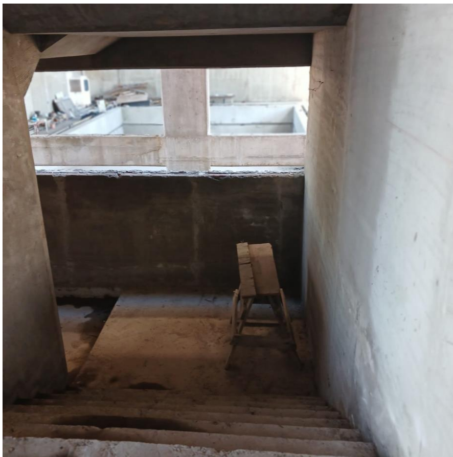
Imagen Z Ref.: Vista desde escalera primer Piso - Enero 2025
