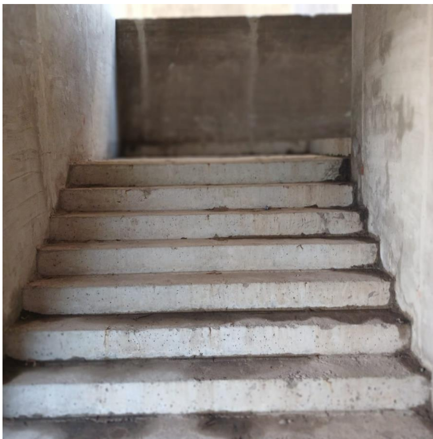
Imagen Y Ref.: Vista Sala de máquinas, orientac - Enero 2025
