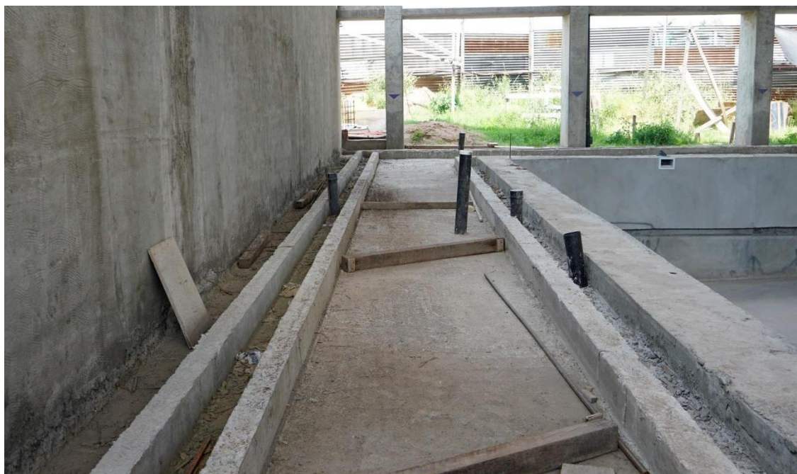
Imagen I. Ref.: Vista interior sobre Contrapiso armado perimetral de la pileta. - Enero 2025
