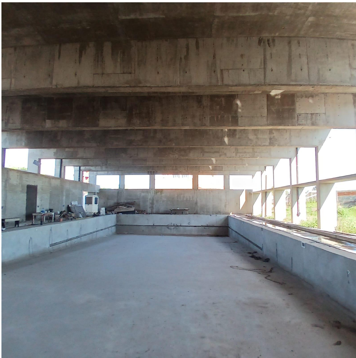
Imagen G. Ref.: Vista peatonal interior sobre Pileta de Hormigón Armado. - Enero 2025
