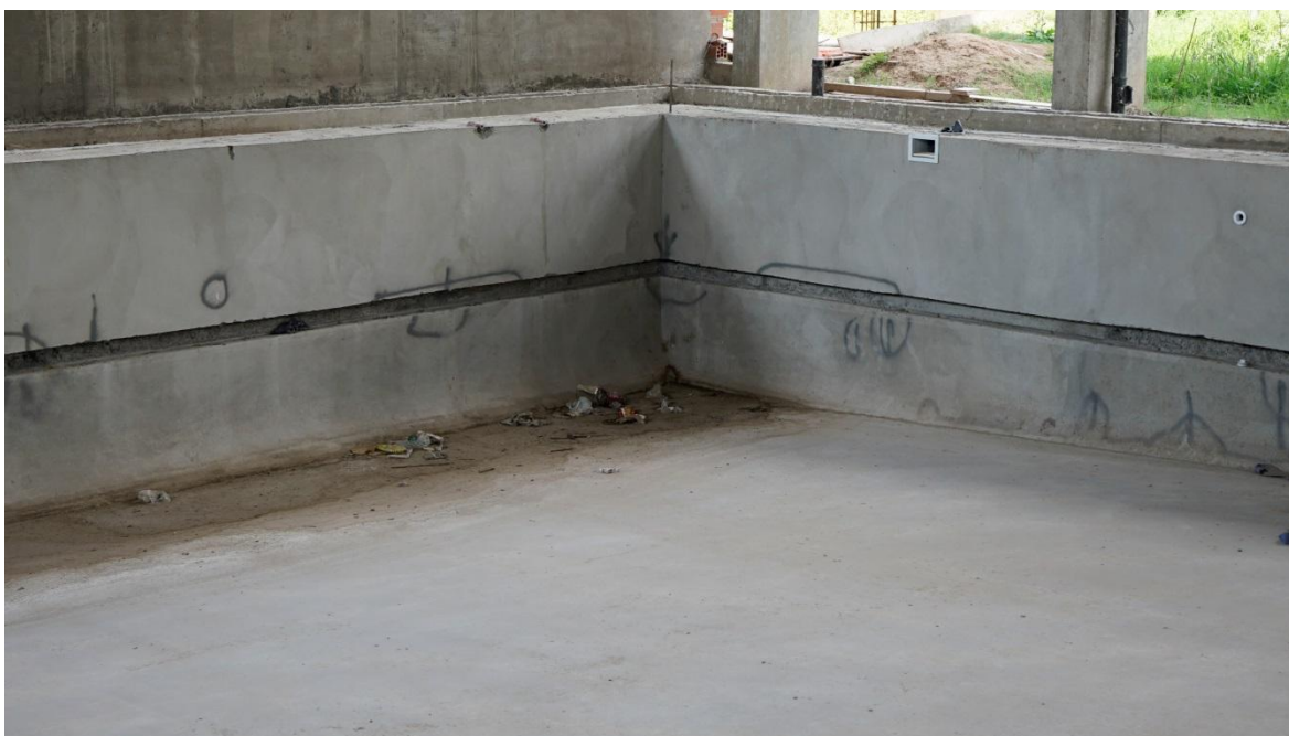
Imagen L. Ref.: Vista interior sobre fondo de pileta de hormigón armado. Borde de descanso, escalón bañista. - Enero 2025
