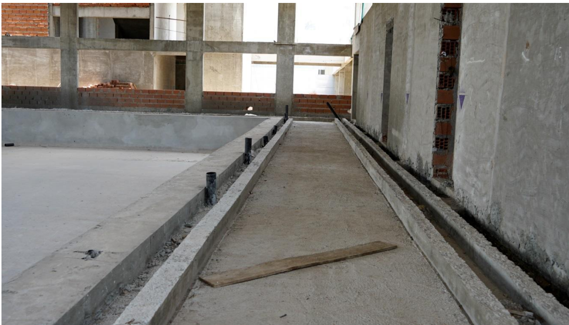
Imagen M. Ref.: Vista interior sobre Contrapiso armado perimetral de la pileta. - Enero 2025
