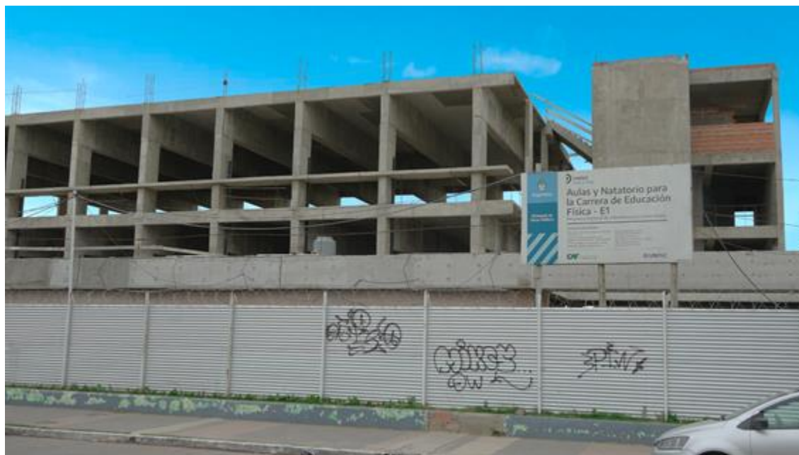
Imagen B. Ref.: Vista peatonal sobre vereda a Fachada, calle Alem. - Enero 2025
