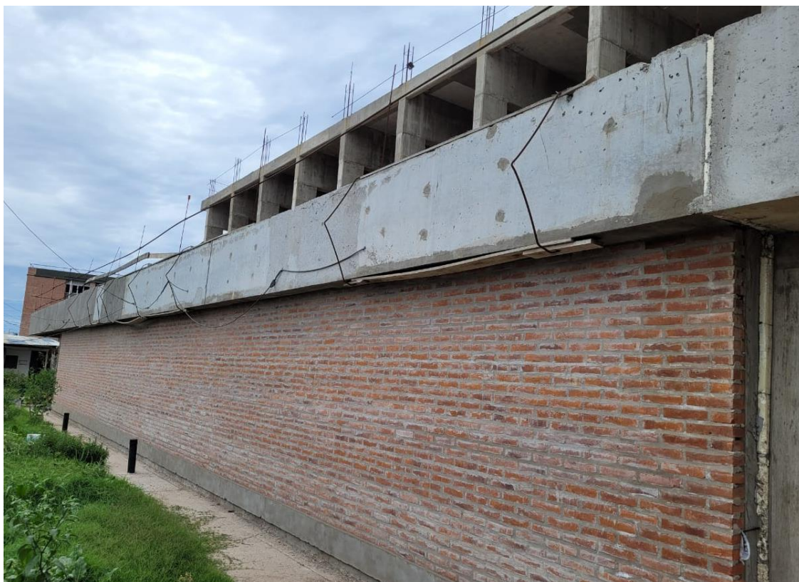
Imagen R. Ref.: Vista de Frente Vestuarios - Enero 2025
