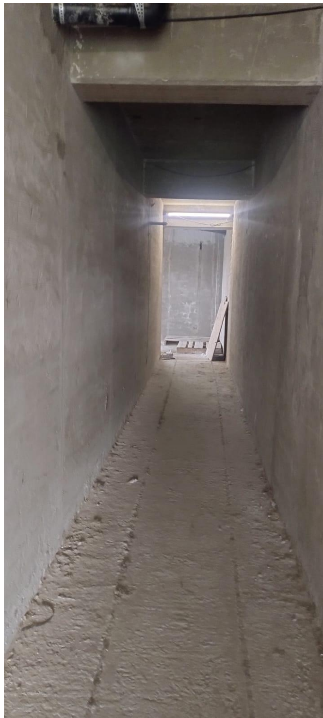
Imagen O. Ref.: Vista peatonal sanitarios - Enero 2025
