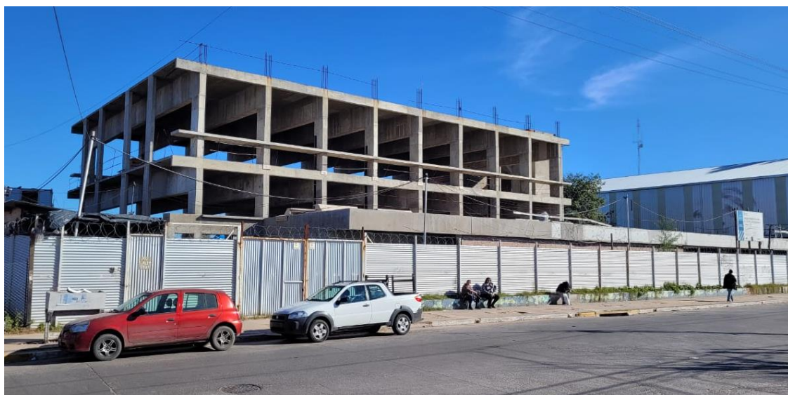
Imagen A. Ref.: Fachada sobre calle Alem - Enero 2025
