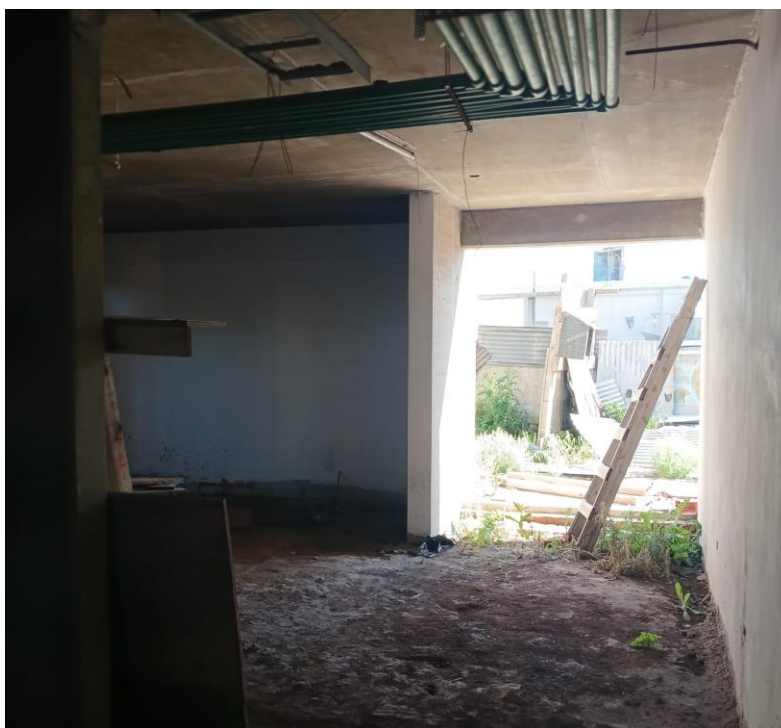
Imagen W Ref.: Vista Sala de máquinas, orientación hacia Vías - Enero 2025
