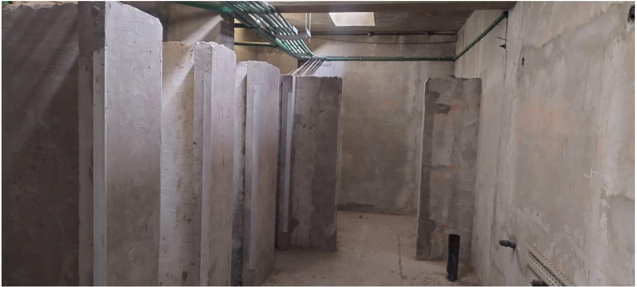
Imagen P. Ref.: Vista peatonal sanitarios masculinos - Enero 2025
