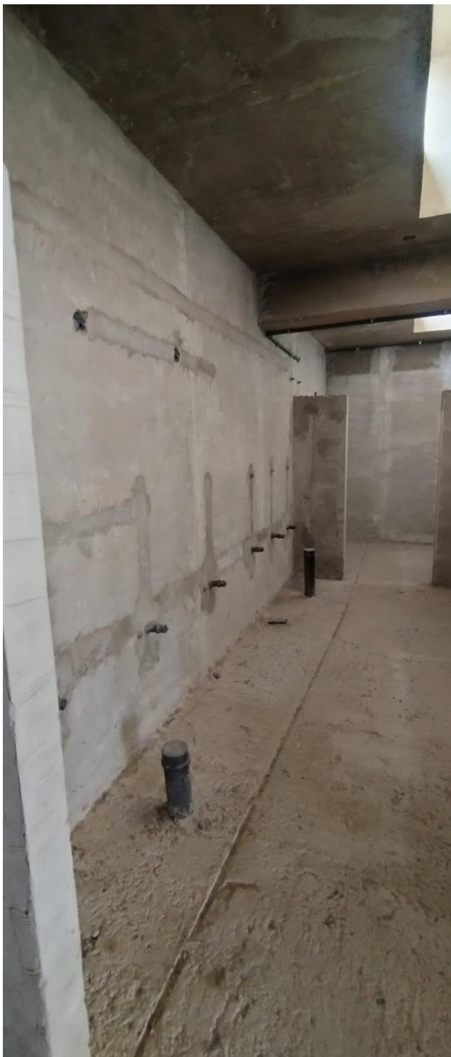
Imagen Ñ. Ref.: Vista peatonal sanitarios masculinos, Sector bachas y mingitorios - Enero 2025
