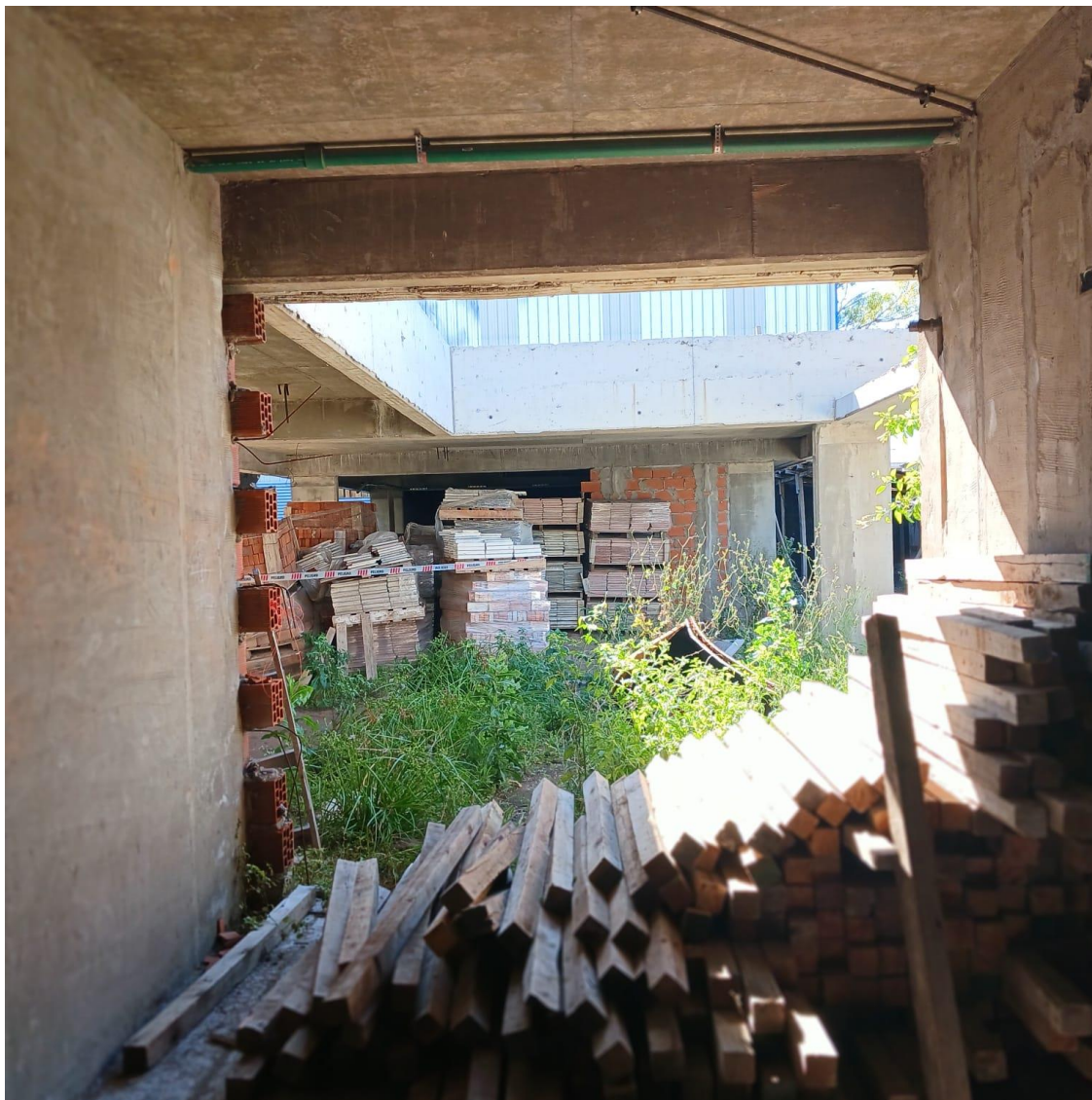
Imagen E. Ref.: Vista peatonal sector enfermería - Enero 2025
