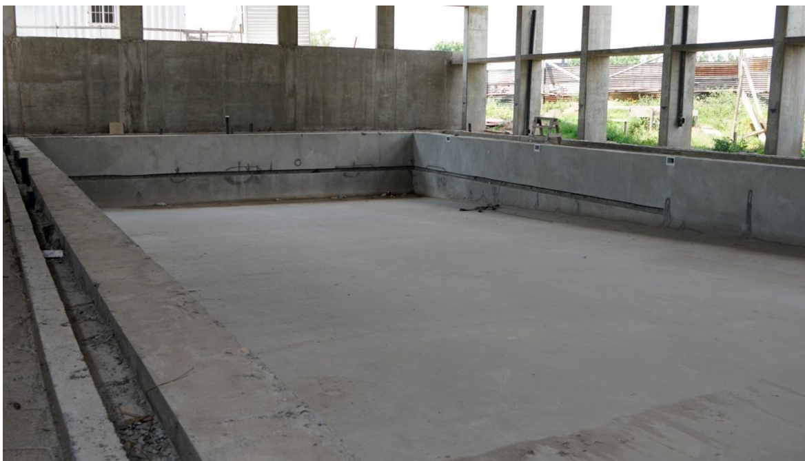
Imagen K. Ref.: Vista peatonal interior sobre Pileta de Hormigón Armado. - Enero 2025
